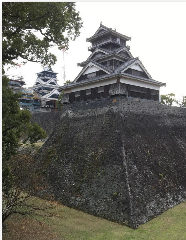
(奥が工事中の熊本城天守閣, 手前は宇土櫓)
